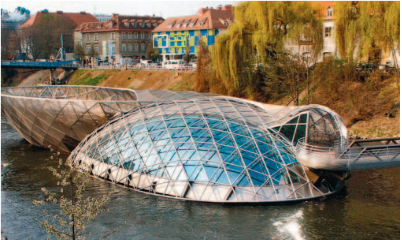
Die Acconci-Insel („Murinsel“), benannt nach dem New Yorker Stararchitekten, der die als leicht-schwebende Konstruktion geplant hat, nicht als den schwerfälligen Metallhaufen, der jetzt im Stadtzentrum in der Mur liegt. Die Insel ist als Steg verwendbar, hat aber sonst keine Funktion, weil die Tribüne, eigentlich für Freiluftveranstaltungen konzipiert, aus Lärmschutzgründen nicht bespielt werden darf und das Café keinen Pächter findet.
