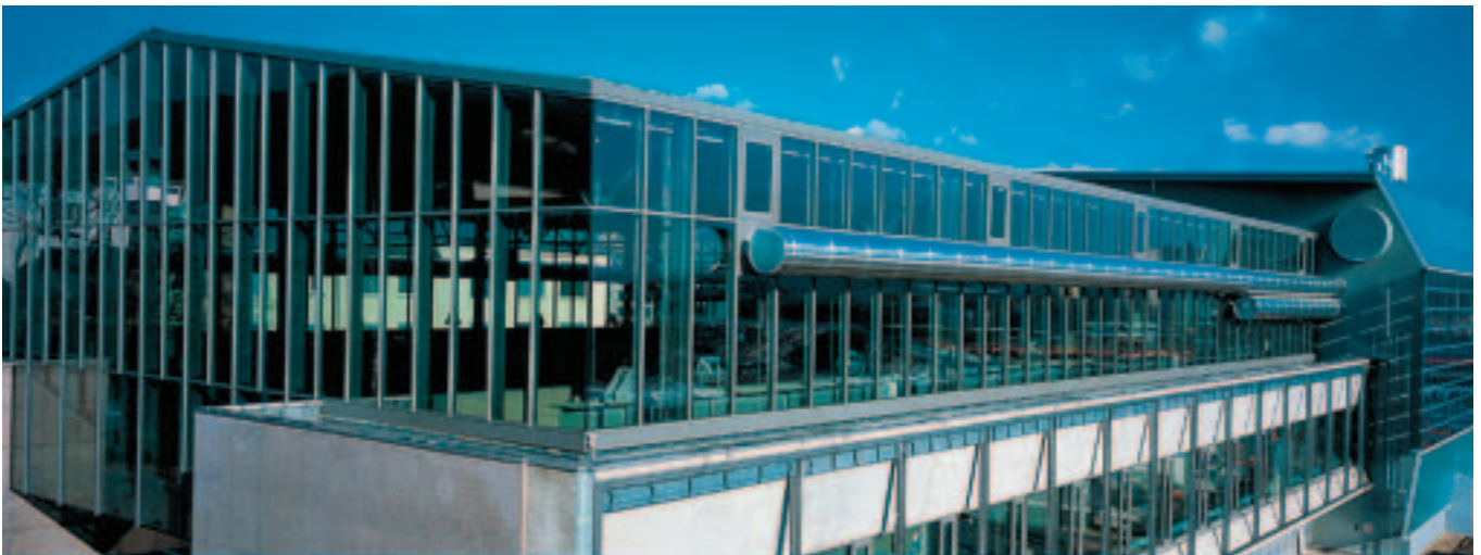
Oben: Die List-Halle, im Privatbesitz befindlich, aber mit öffentlichen Geldern errichtet und instand gehalten. Sie wird v.a. vom Vorzeigefestival „steirischer herbst“ genutzt, der aufgrund der ungünstigen Konditionen 2004 fast in den Konkurs geschlittert wäre.
